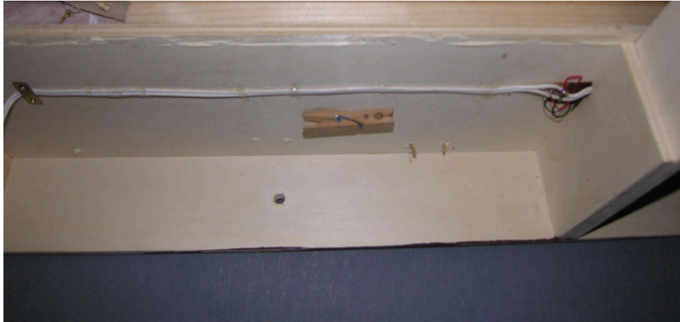
Abbildung 6: Wäscheklammer zur Kabelaufhängung während des Transportes
